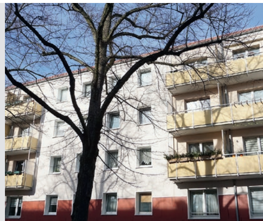
Schillerstraße 42 - 48, Fassadenreinigung, Frühjahr
