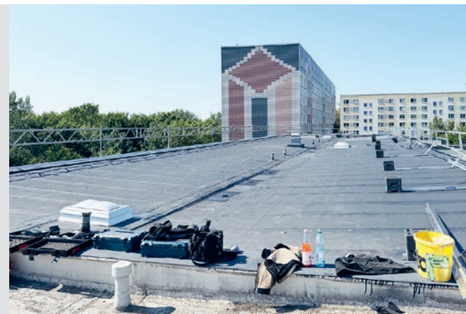
Flachdacherneuerung in Buch, August
