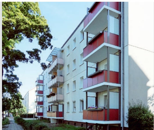
Fontanestraße 40 - 42, Balkonanbau, Sommer
