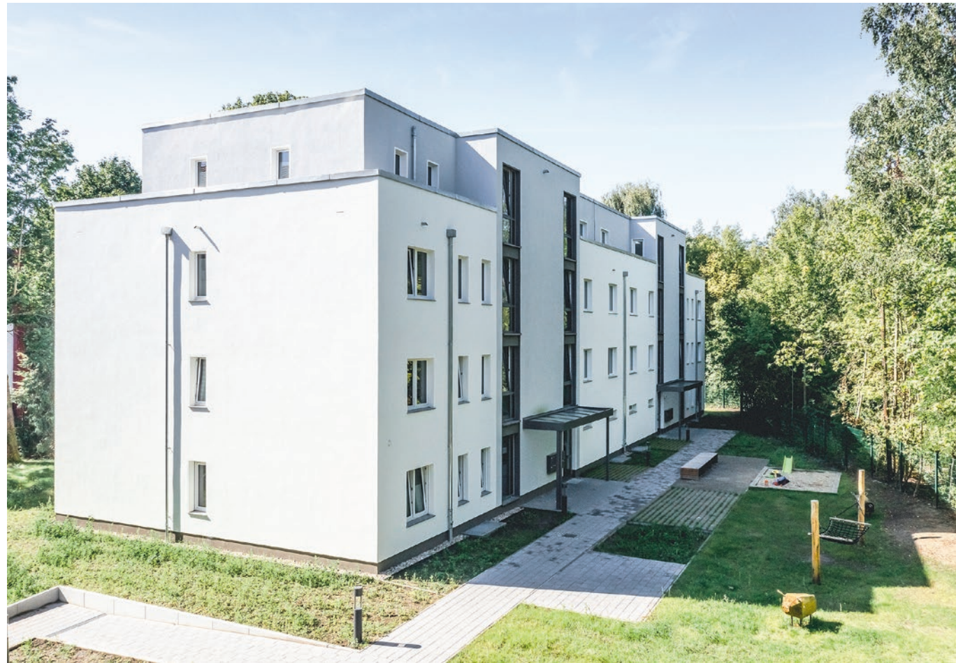
Neubau Lessingstraße 54 d, 54 e, Fertigstellung Mai
